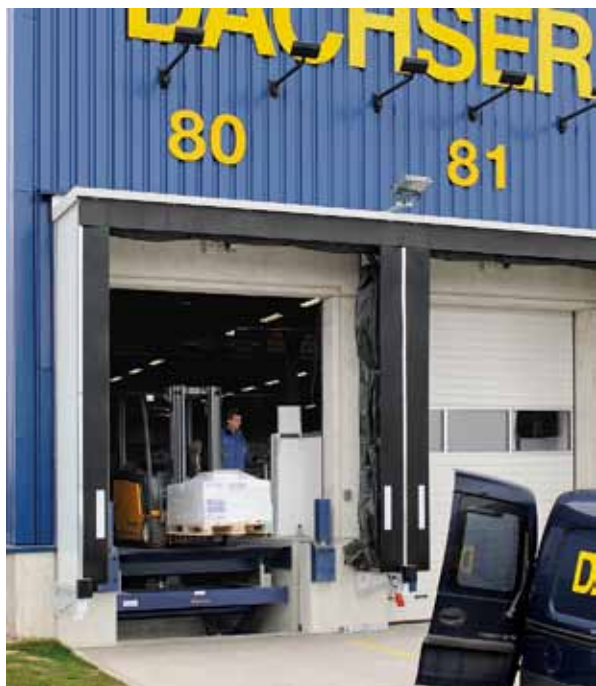
Zariadenie Liftleveler je kombináciou nakladacieho mostíka s vysúvacím klinom a nožnicovej zdvíhacej plošiny
